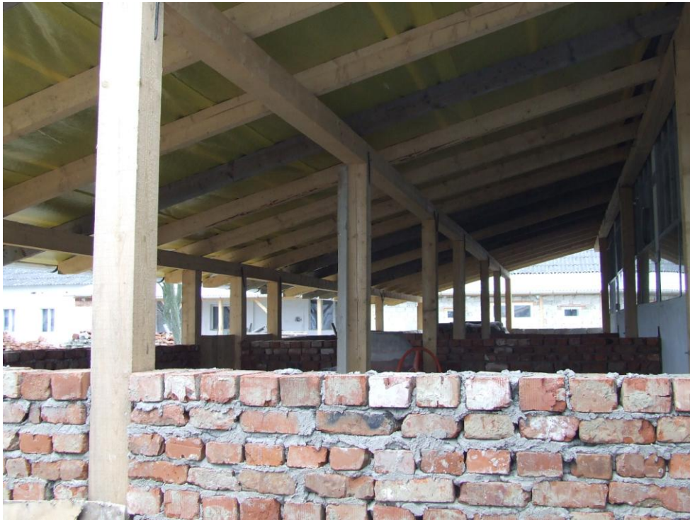
125. kép Új szárny épül a sertéstelepen (fotó: Kajner Péter)
